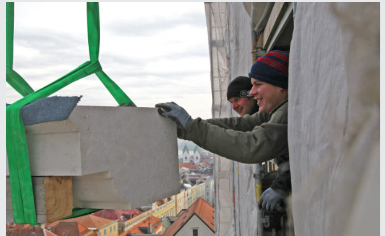
Passauer Dom, Steinmetzen beim Transport eines Gesimsstücks für den Nordturm; Foto: © Staatl. Dombauhütte Passau
