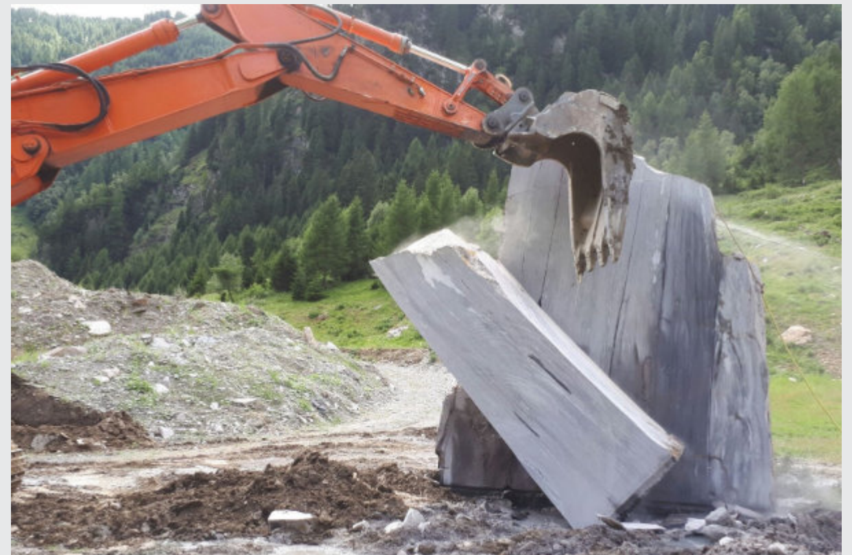
Abbau des Rabensteins: Dieser Stein kam durch einen Felssturz zu Tale; Foto © südtirol.stein
