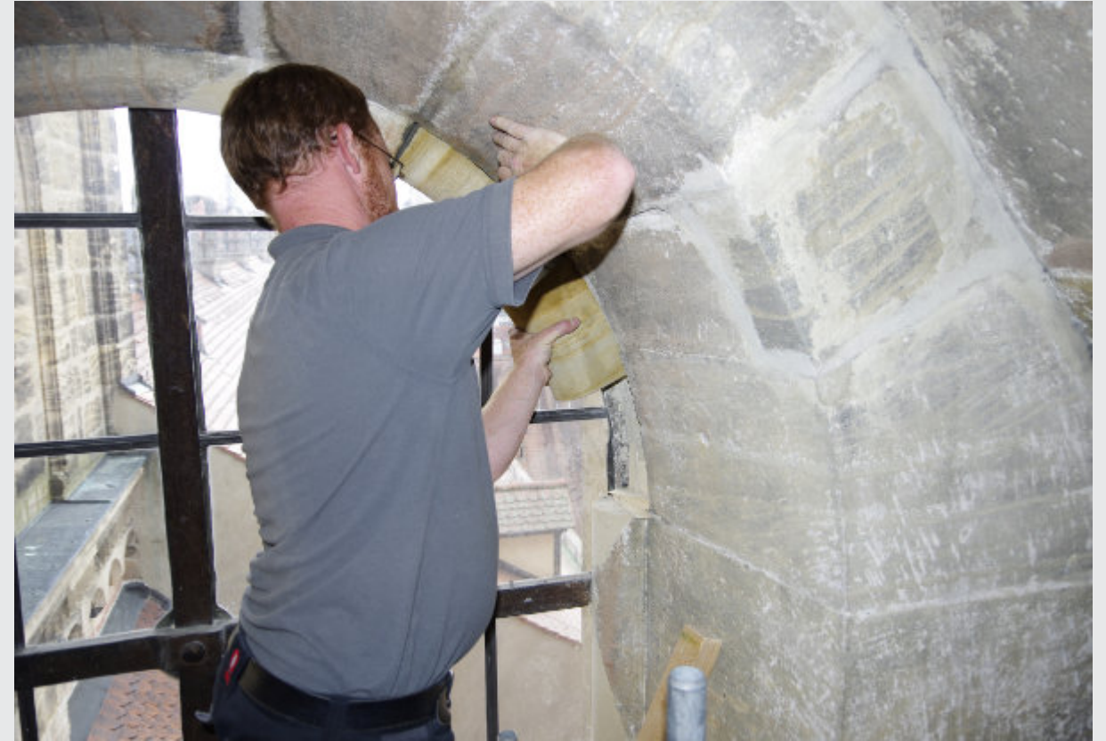
Bamberger Dom, Arbeiten an der Fensterleibung; Foto: © Ulrich Först
