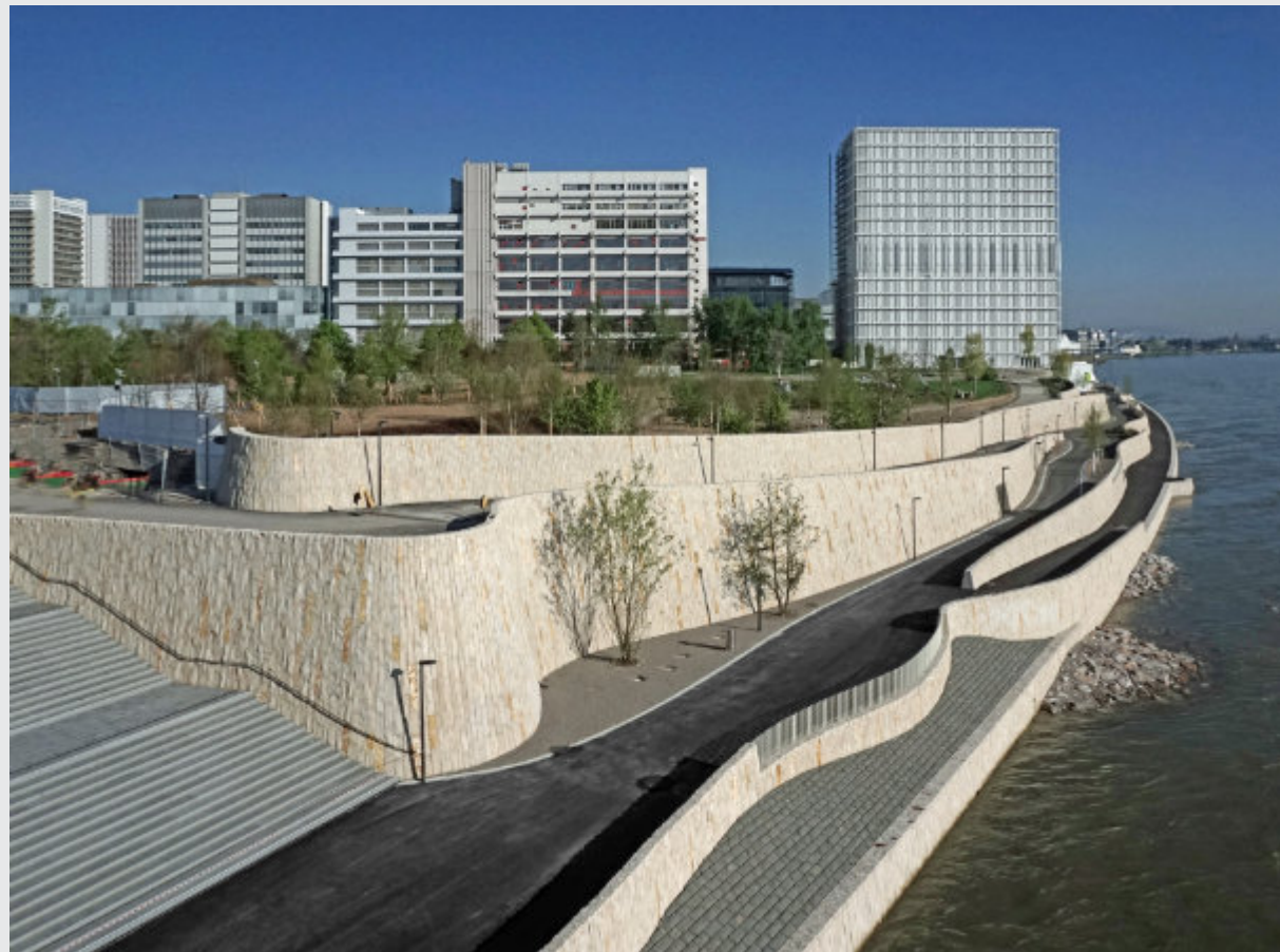
Rheinuferweg St. Johann in Basel | Wandverkleidung einer Stützmauer mit Dietfurter Kalkstein gala®
